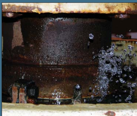
Le perdite portano alla corrosione delle apparecchiature e a premature rotture dei cuscinetti
